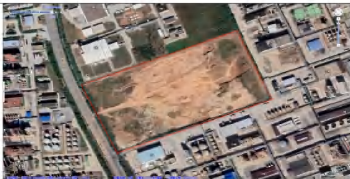
2022年，项目地块内新区第二污水处理厂转运站拆除搬迁，地块内经过平整，待开发。
