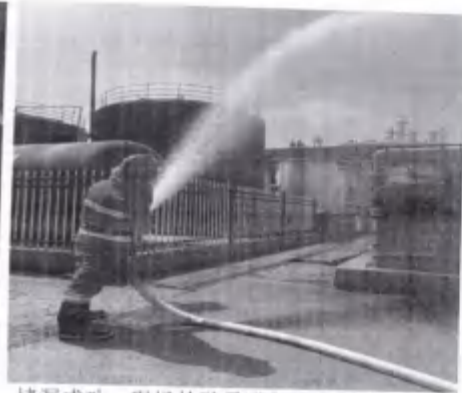
堵漏成功，现场的酸雾进行覆盖消除
