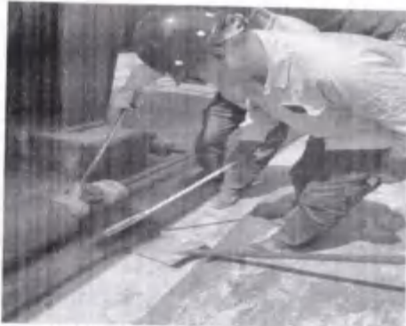
进入现场进行清理
