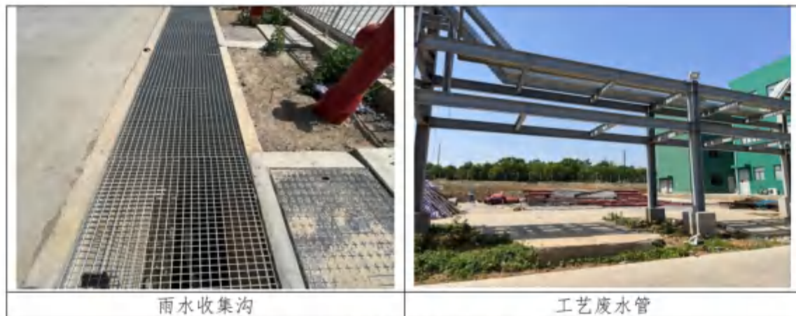
图2.2-3 项目地块管道示意图
