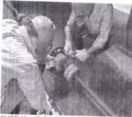
发现险情，检维修人员进行堵漏处理
